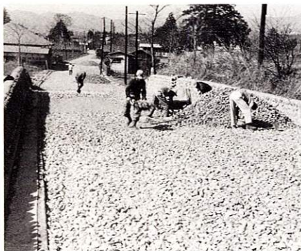
昭和30年代中頃の道路整備風景
