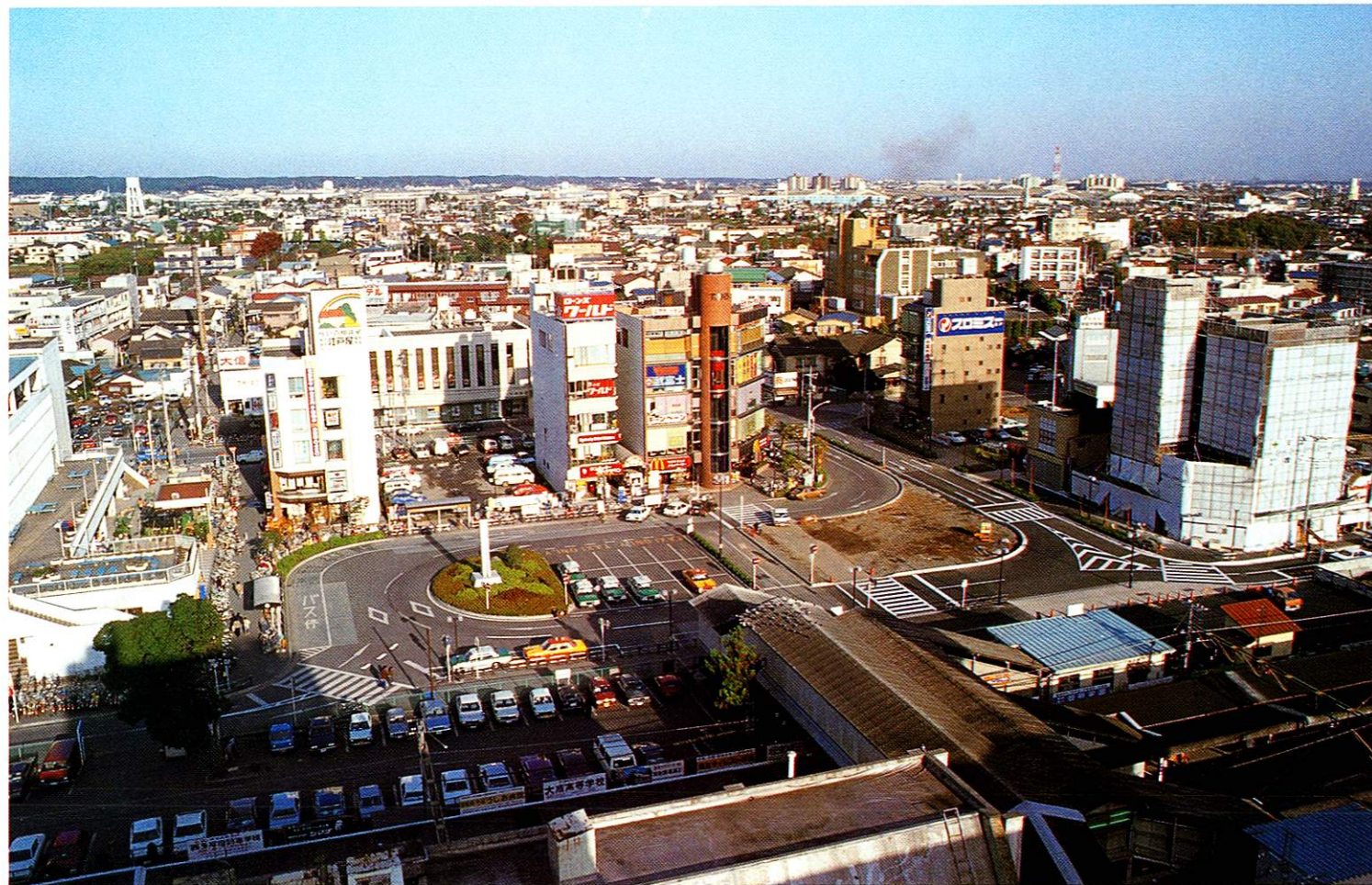
区画整理完成まじかの福生東口駅前広場
