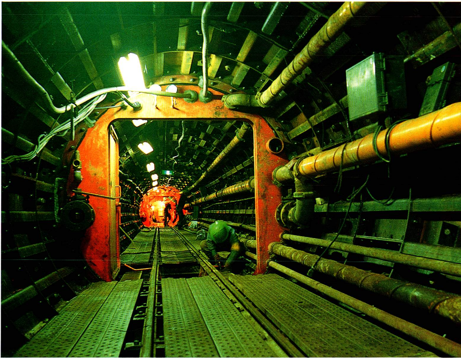
完成をめざして最終スパート、公共下水道事業(幹線工事)
