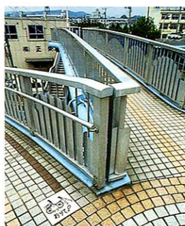
タイルが美しい歩道橋
