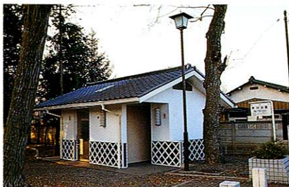
熊川公園にあるアメニティトイレ
