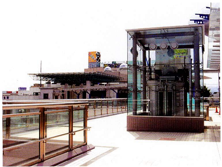
ペDESTリアンデッキのエレベーター
